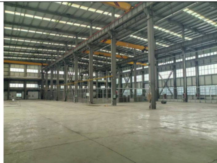
租赁车间内部（现状空置）
