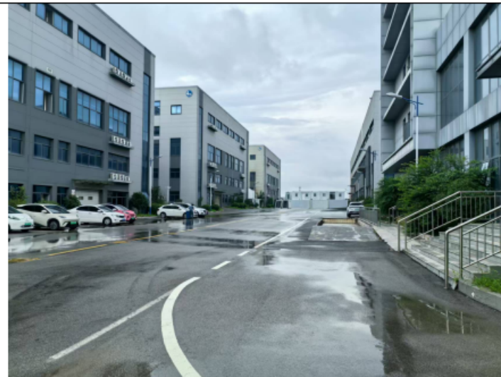
产业园内部道路
