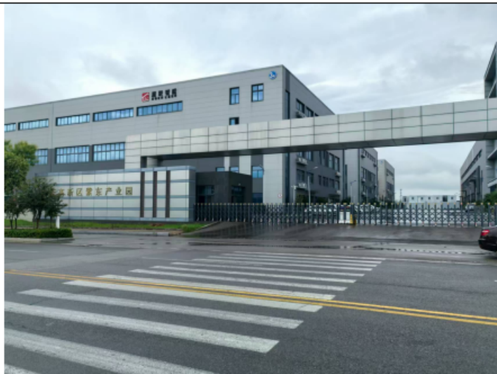
产业园南侧出入口
